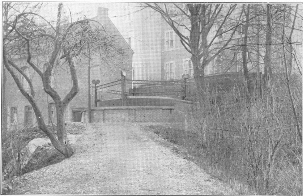
WASSCHERIJ EN GASFABRIEK V66R DE AFBRAAK
