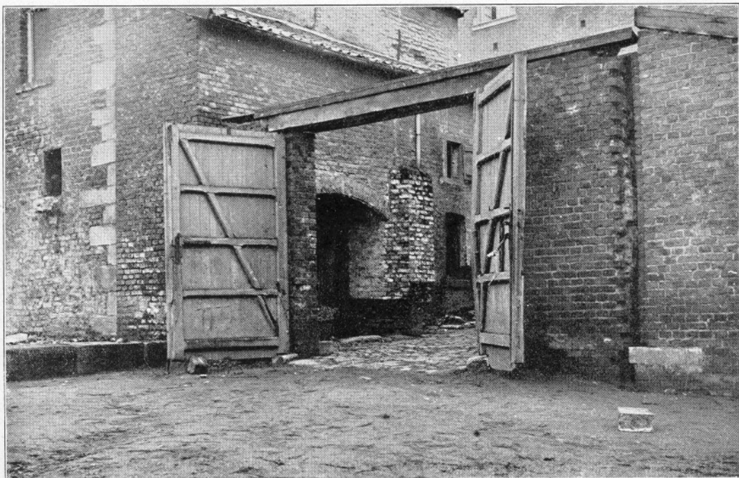
INGANG VOORMALIGE BASSE-COUR
